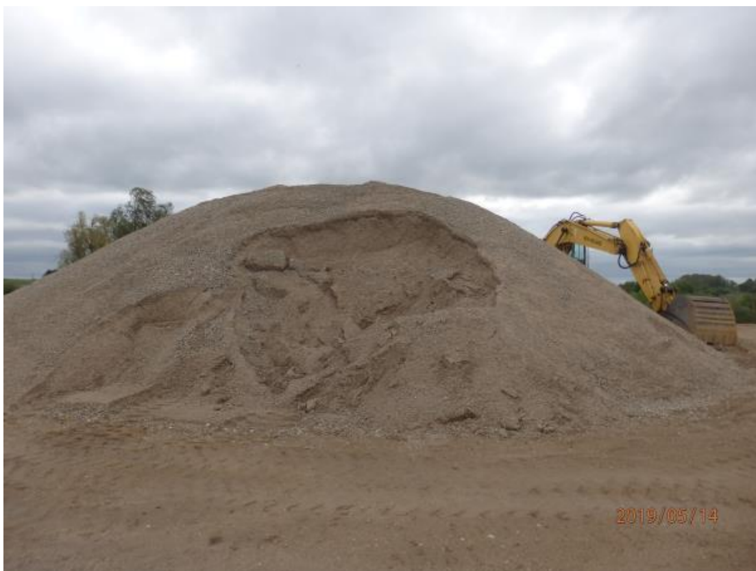
10. att. Drupinātu laukakmeņu krautne ceļu klātņu remontam [1]
